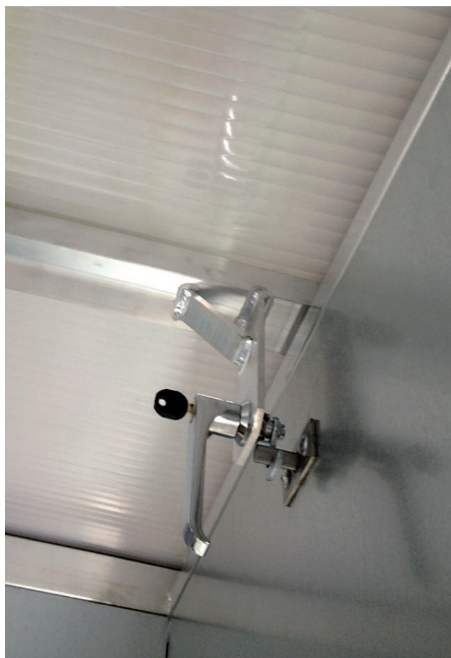
Každý výlez je vybaven klikou s vložkou, a dvěma klíčky v sadě.
